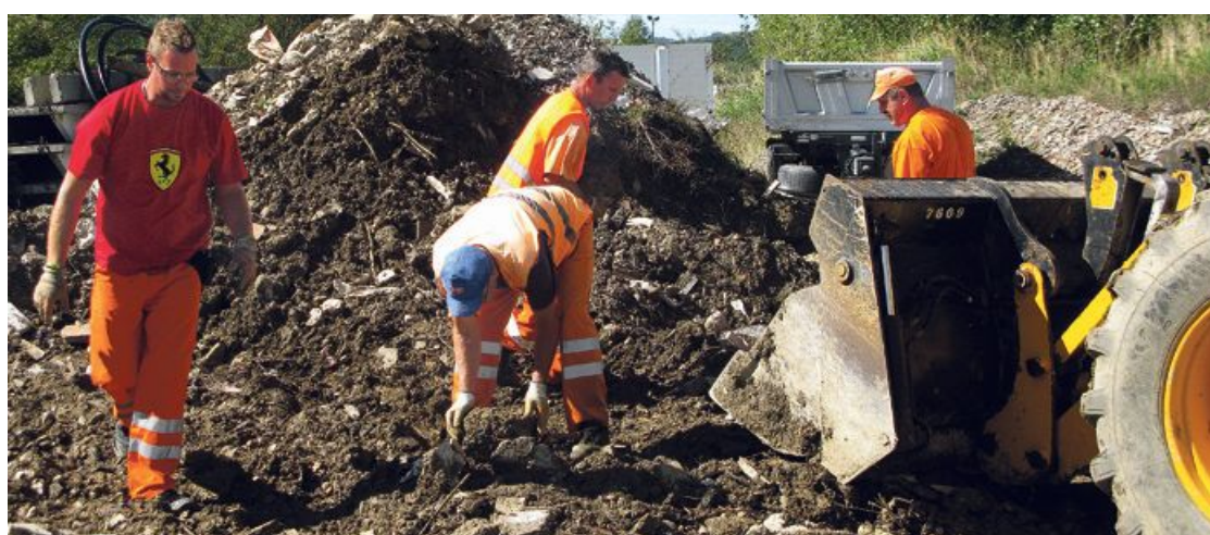
Prikaz čiščenja divjega odlagališča gradbenih odpadkov in postopkov njihove predelave. FOTO KATJA ŽELJAN
